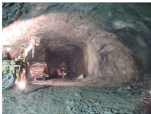
图 8 主变室第 1 层开挖与支护
