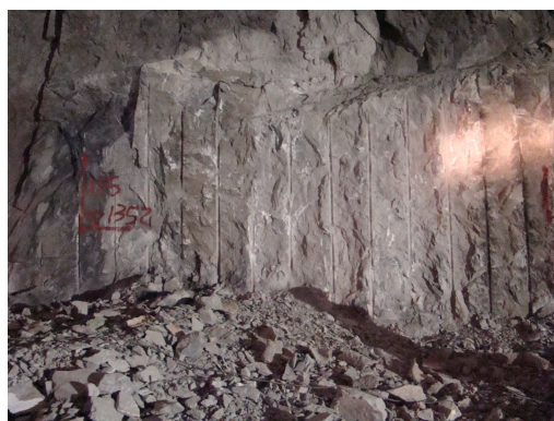
图 7 主厂房第 2 层开挖后下游边墙
